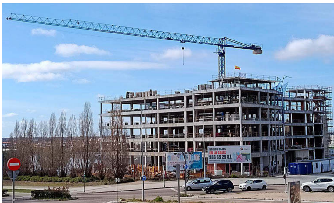
Edificio en construcción en la zona sur de la capital vallisoletana. E. M.
