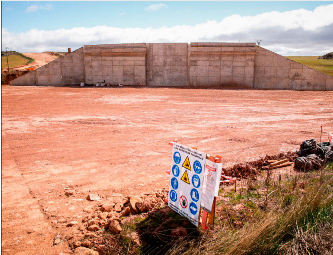
Una de las construcciones del tramo Fuensaúco-Villar del Campo de la A-15. MONTESEGUROFOTO
