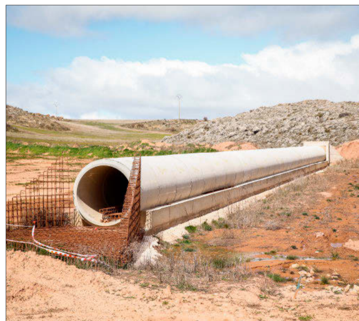
Infraestructura de drenaje en el tramo en obras de la A-15. MONTESEGUROFOTO
